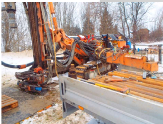
Forage pour puits d'injection 6"
