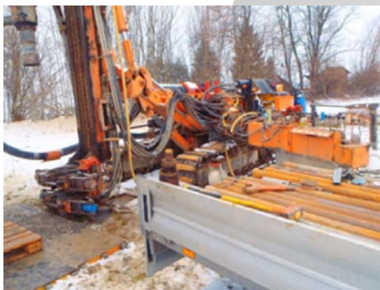
Bohrung für Injektionsschacht 6"
