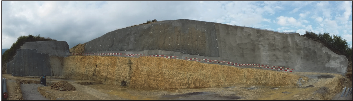
Photo du site une fois les travaux finis, septembre 2016.
